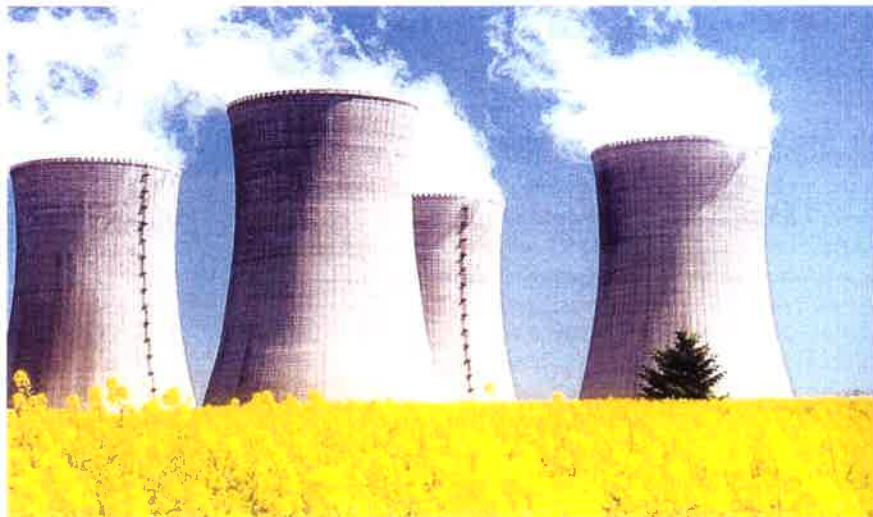
Vodní pára stoupající z chladicích věží 1 a 2 bloku atomové elektrárny Mochovce - ilustrační foto
